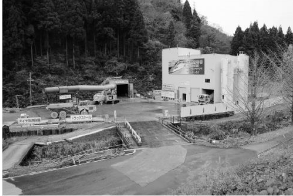
新北陸トンネル大桐工区は SEC 工法を採用する
